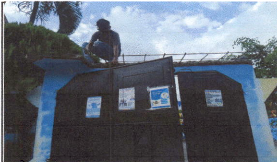
FOTO 9: Sustitución de portón de metal
