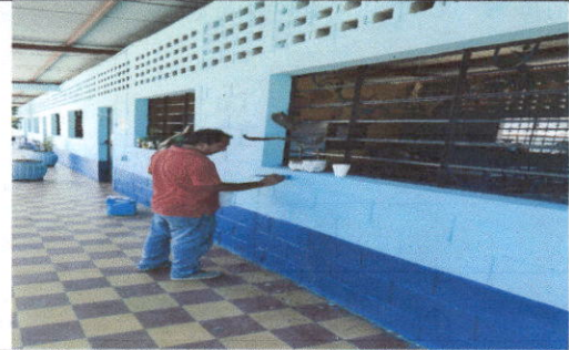
FOTO 8: Pintura en muros exteriores e interiores
